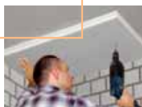
Durch das Element wird in die Decke vorgebohrt
