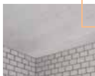
Die Betondecke muss sauber, eben und trocken sein
