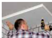
Befestigungsmittel anziehen
