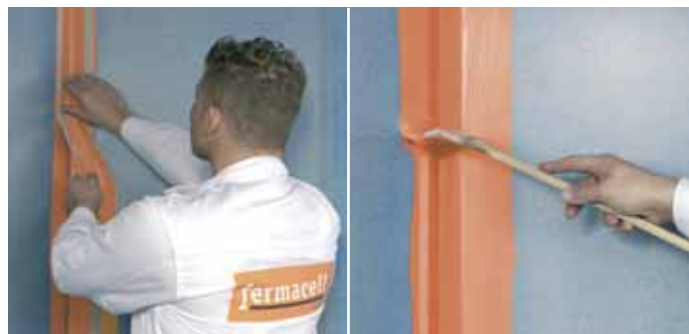
Figure 2 : Presser la bande d'étanchéité FERMACELL dans le lit d'étanchéité encore liquide et, en un 2 ème passage, la recouvrir complètement d'étanchéité liquide
