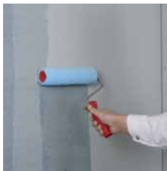
Figure 1 : Appliquer la couche de fond FERMACELL
