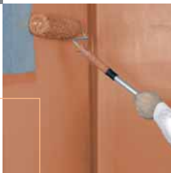
Figure 3 : Appliquer au rouleau l'étanchéité liquide FERMACELL en 2 passages (épaisseur minimal 0,5 mm)
