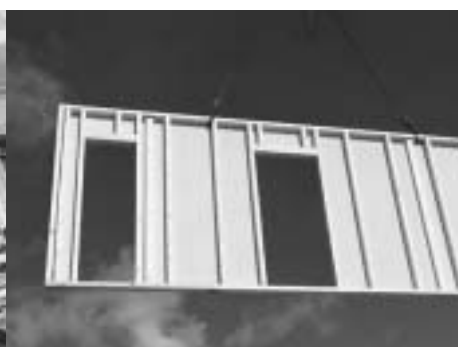
Figure 4 : Transport sur le chantier à l'aide d'une grue
