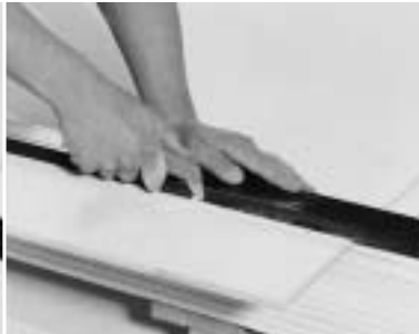
Figure 12 : Entaillage sur la ligne de rupture
