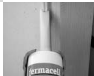
Figure 20 : Guidage de la cartouche de 310 ml le long du chant de la plaque à l'aide du nouvel embout : L'embout garanti un dosage précis de la colle pour les plaques d'une épaisseur de 10 mm et 12,5 mm. Pour les plaques de 15 et 18 mm, il est nécessaire d'adapter l'embout.
