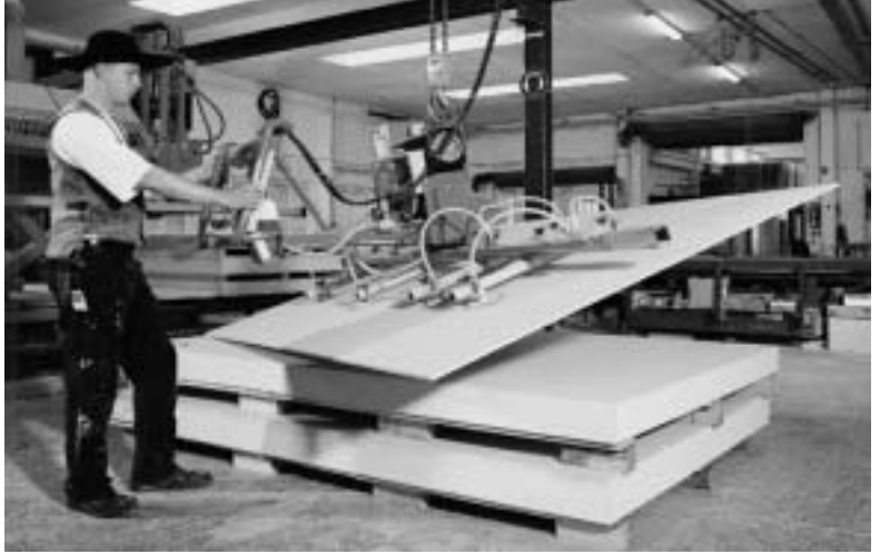
Figure 2 : Transport des plaques FERMACELL avec un appareil de levage à ventouses
