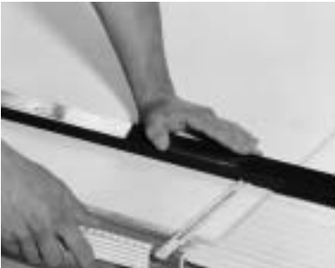
Figure 11 : Détermination de la ligne de rupture
