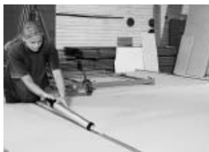
Figure 19 : Application de la colle à joints FERMACELL avec la gaine alu pratique de 580 ml
