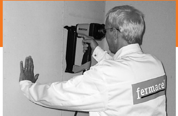
Agrafage dans l'ossature bois
