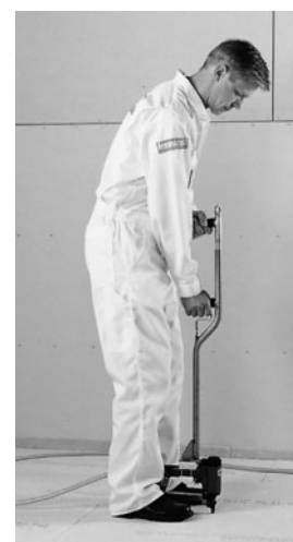
Fixation rationnelle des sols à l'aide d'agrafes
