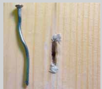
Déformation plastique d'un élément de fixation
