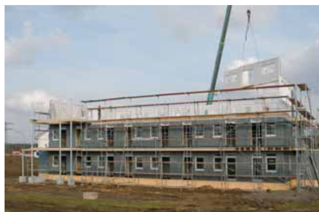
Bâtiment à plusieurs niveaux dans la construction bois avec les plaques de plâtre armé de fibres FERMACELL.
