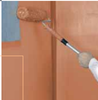
Abb. 3: FERMACELL Flüssigfolie mit der Rolle 2x flächig auftragen (Gesamtstärke min. 0,5 mm)
