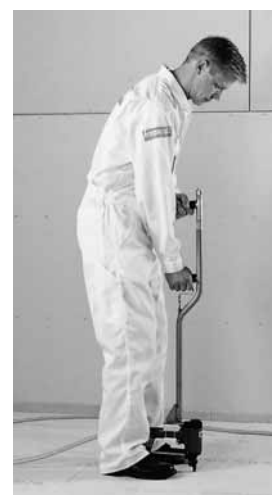
Rationelles Verarbeiten durch Klammern im Bodenbereich
