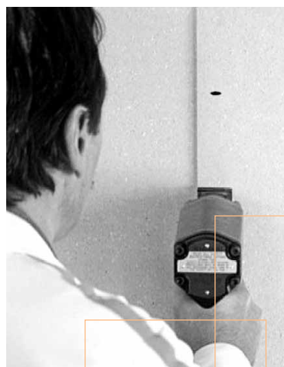
Rationelles Verarbeiten durch Klammern im Bodenbereich
