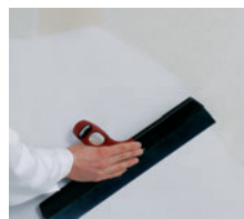
Großflächig auftragen und abschließend sauber abziehen
