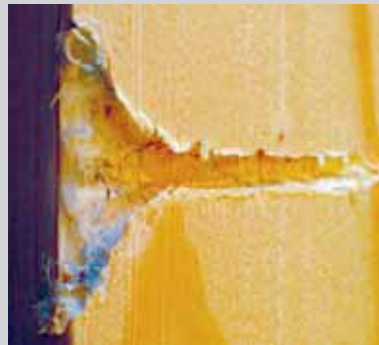
Plastische Verformung in Holzträger (Lochleibungsfestigkeit klein)
