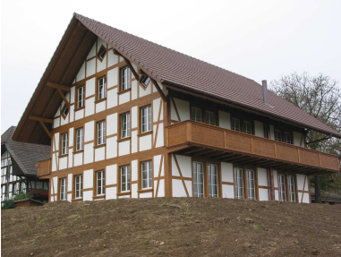
Neubau Familie Allemann in Allmendingen Holzbau: Wüthrich Ulrich, Allmendingen Gipserarbeiten: Hofer AG, Bauunternehmung, Oberthal
