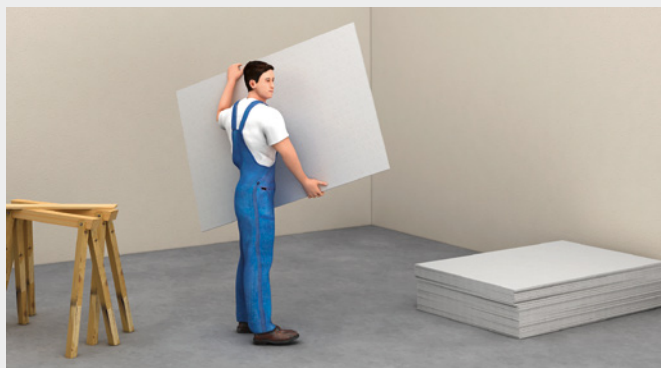
Plaque par plaque, on les transporte verticalement
