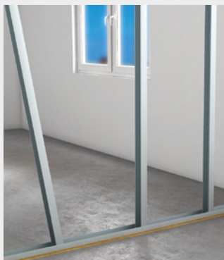
Pose des montants métalliques CW
