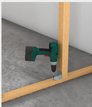
Pose des montants en bois avec une équerre ou des clous
