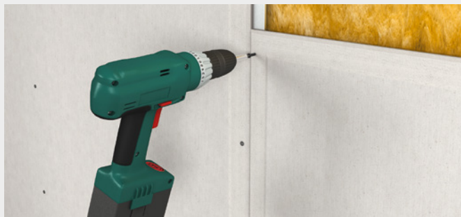
Visser dans un profilé métallique de 0,6 mm
