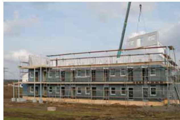
Mehrgeschossiges Gebäude in Holztafelbauweise mit FERMACELL Gipsfaser-Platten.
